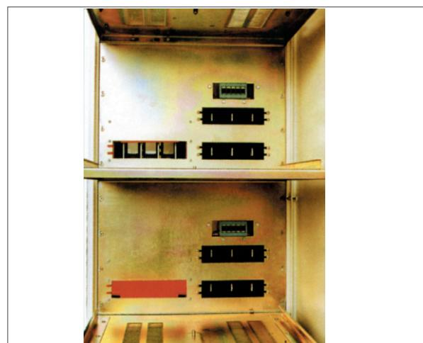
f. 功能单元隔室采用金属隔板隔开。
