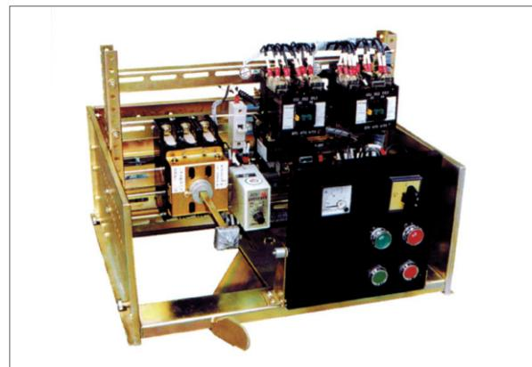
b. 抽屉层高度模数为200mm，分为 - 单元、1单元、1-单元、2单元、2-单元、3单元六个尺寸系列。单元回路额定电流630A及以下。
